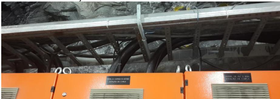
Fig. 9 – acionamento para motor 500CV
